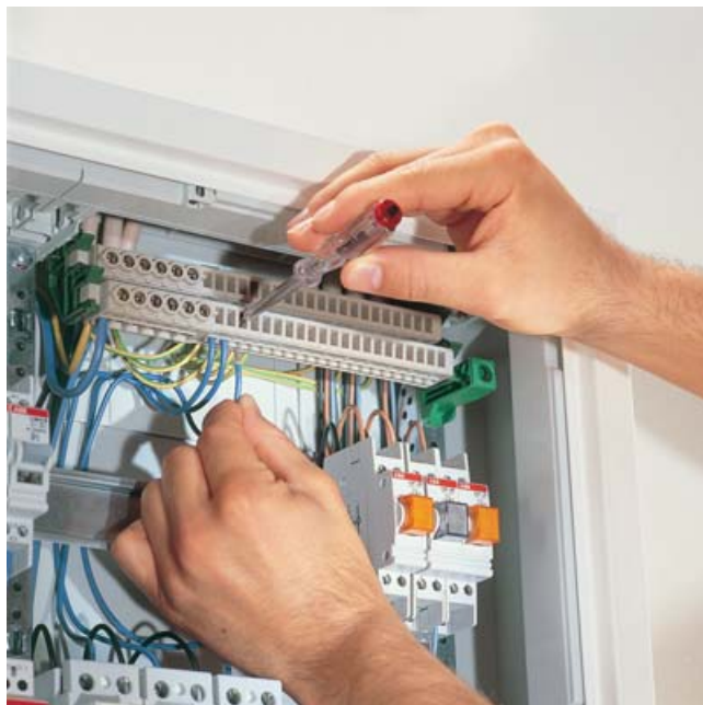
Ka mitmekiulised juhtmed saab ühendada neid eelnevalt hülsistamata, vedruklemm avatakse kruvikeerajaga surudes.
