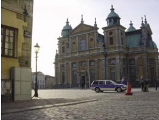
SDCM jaotusseade installeeritud tänavavalgustuse toiteks, Rootsi.
