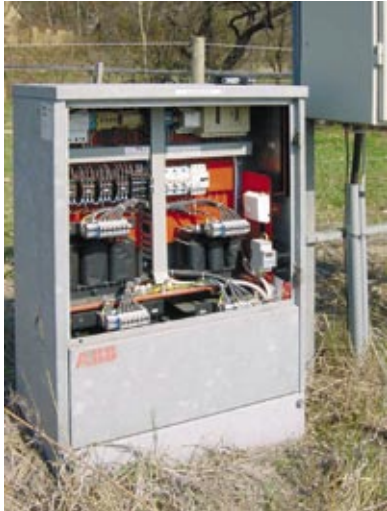
Kapp loogikadetailidele, Kalmar (E22), Rootsi.
