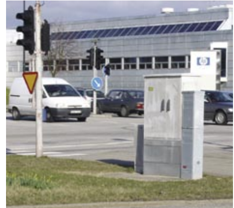
CDCM kapp paigaldatud valgusfooride automaatikaseadmete toiteks, Rootsi.
