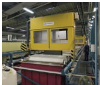
Automaatne töötlemine enne pulbervärvimist.
