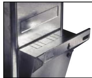
Kapi tagaosas ettevalmistatud (kuid suletud) avad kaablikanalite jaoks.
