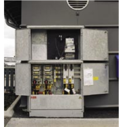
McDonalds Rootsis kasutab standardlahendusena Kabeldoni kappidel põhinevat ja väljaspool hoonet paiknevat jaotusseadet.
