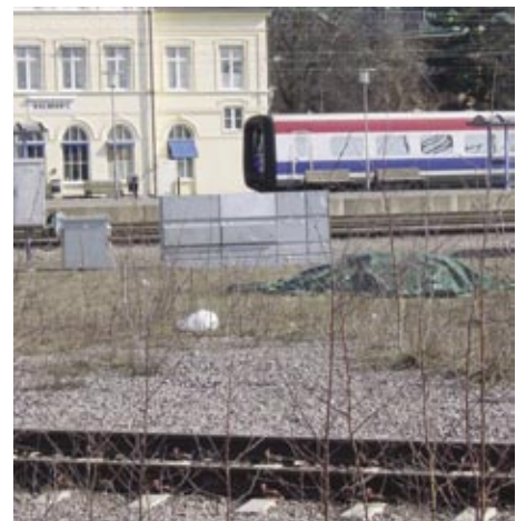
Kaablijaotuskapp signalisatsiooniseadmete toiteks, Kalmar C, Rootsi.
