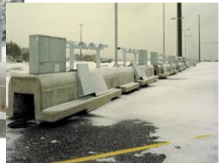
Jaotuskapp külmutuskonteinerite toiteks Göteborgi sadamas, Rootsi.
