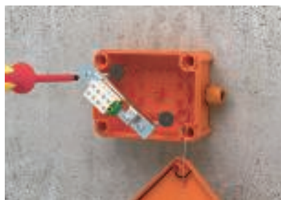
Tuletõkke-kruviankru montaaž läbi looga ja FireBox'i põhja
