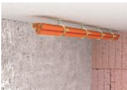
Kaablite koondatud paigaldus lae alla
