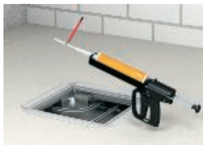
Segatoru kasutamine pikendusena tuletõkkevahu sisestamisel
