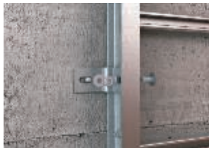
Montaaž kruvitavate kinnitusnurgikutega
