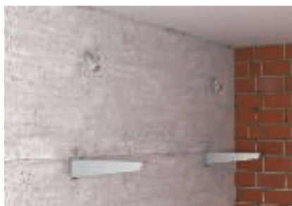
Kandurite ja ühendusdetailide montaaž seina külge
