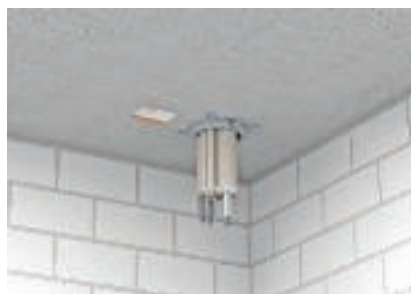
Paigaldamine lae alaküljele metalltüüblitega
