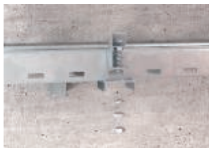
Ühendusdetaili kaldasendis montaaž kuuskantpoldi ja kuuskantmutritega
