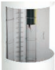
Bandaažitud püsttrass tuulegeneraatori tornis
