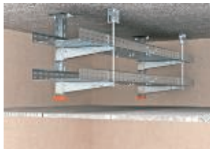
Kahekihiline rippkinnitus lakke - kandurite ühepoolse paigutusega
