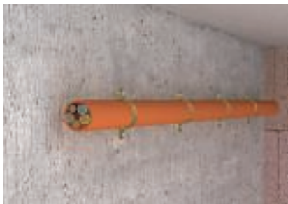
Kaablite horisontaalne montaaž seina külge
