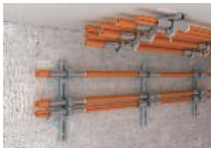
Horisontaalne montaaž lookklambrite ja vastasvannidega seina külge ning lae alla
