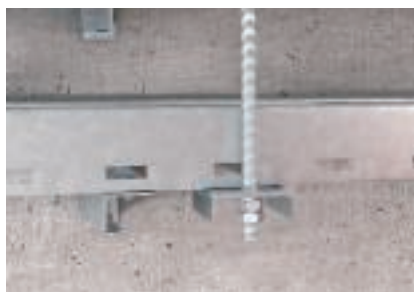
Vertikaalse keermelati kinnitus ühendusdetaili külge
