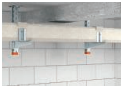
Riputatud laepaigaldus I-kanalina
