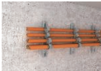
Kaablite horisontaalne montaaž lookklambritega seina külge
