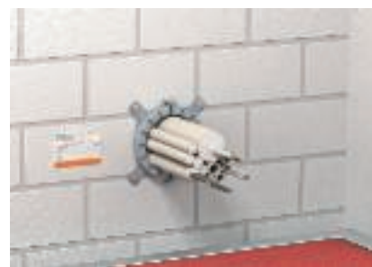
Installatsioonitorude tähistatud tuleõõne
