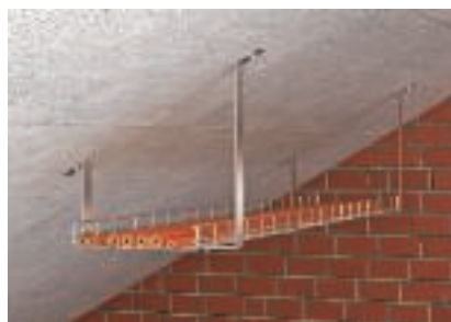
Montaaž kaldlae alla individuaalselt sobitatud laeklambritega
