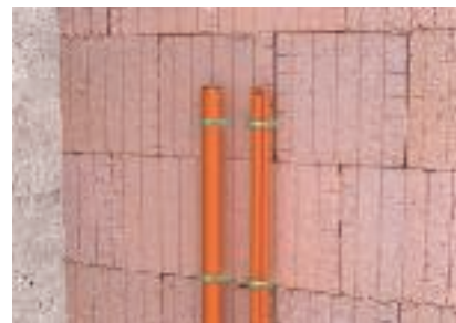
Vertikaalne kaablipaigaldus üksik- või kimppaigaldusena seina külge
