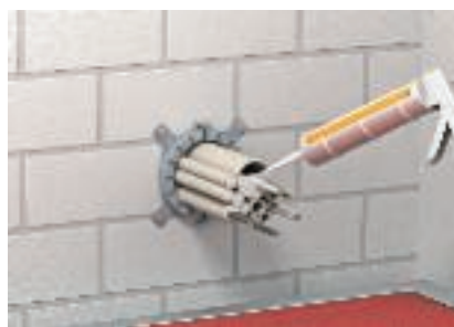
Toruotste sulgemine isoleeriva täitematerjaliga DSX
