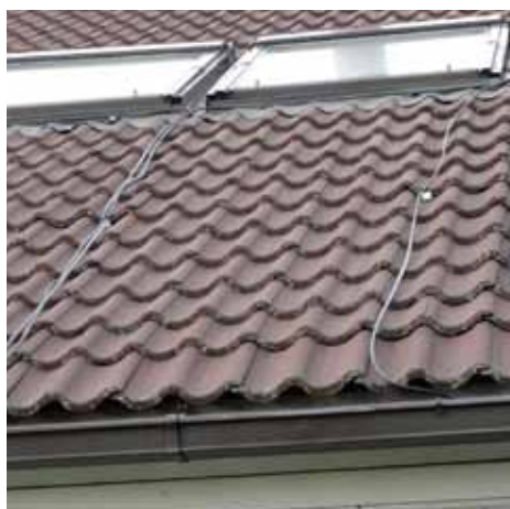
Sulavee äravoolutee tuleb katta kaabliga kuni vihmaveerennini (PILT ON ILLUSTRATIIVNE).
