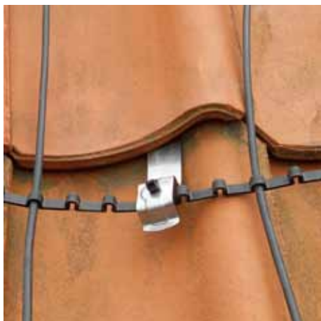
Kivikatuse külge kinnitatakse sulatuskaabel klambrite ja PPN6 kinnitusliistude abil. (PILT ON ILLUSTRATIIVNE)
