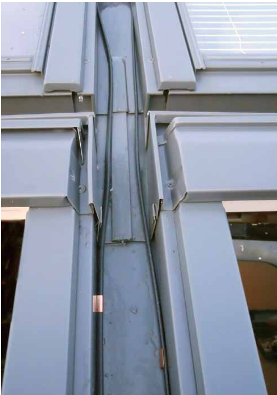
Sulatuskaabli paigaldus kahe kõrvutioleva katuse- akna vahele (PILT ON ILLUSTRATIIVNE).
