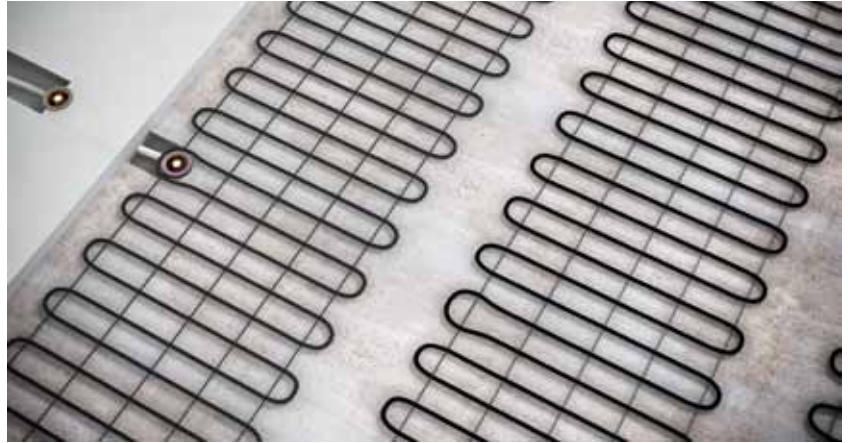
Lume- ja jääandur paigaldatakse sulatatavast alast väljapoole; temperatuuri- ja niiskusandur sulatatavale alale. (PILT ON ILLUSTRATIIVNE)
