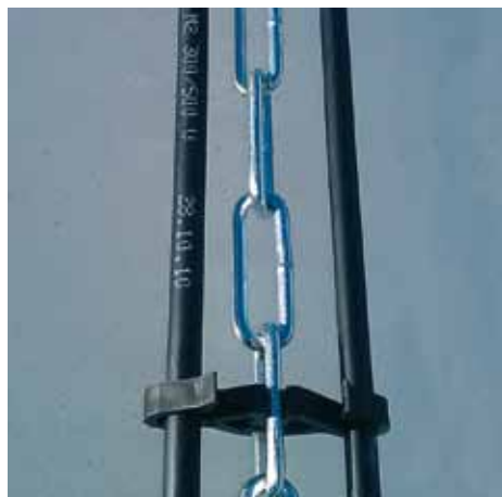
Tash kaabel kinnitatakse püsttorudes ja lumetöкке taha riputusketi külge klambritega PPN10. (PILT ON ILLUSTRATIIVNE)
