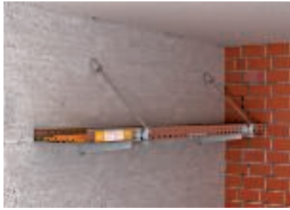
Seinamontaaž kaldu keermelattkinnitusega
