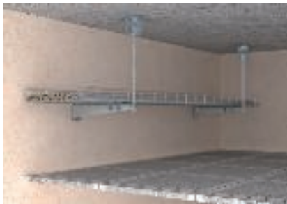
Seinamontaaž, võimalik ühe- ja kahekihiliselt
