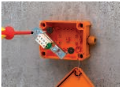
Tuletõkke-kruviankru montaaž läbi looga ja FireBox'i põhja
