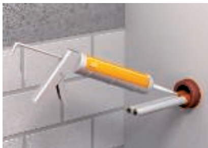
Minitorukesta FBA-DR kasutamine kergetes vaheseintes
