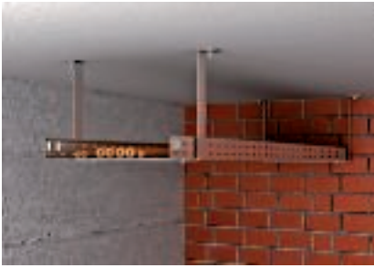
Ühekihiline laemontaaž laeklambri- riga
