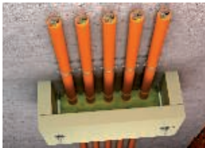
Tõhus toetamiseede tõmbetakistiga ZSE90
