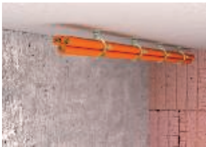
Kaablite koondatud paigaldus lae alla
