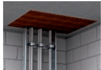
Plokkide tihke paigaldus laeläbiviiku
