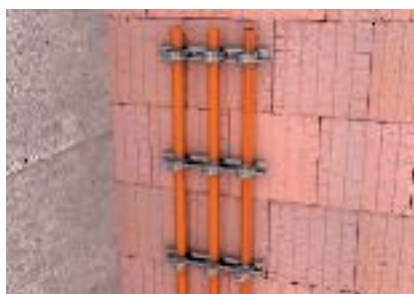
Kaablite vertikaalne montaaž U-klambritega seina külge
