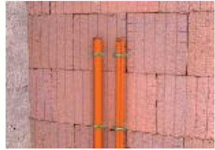
Vertikaalne kaablipaigaldus üksik- või kimppaigaldusena seina külge
