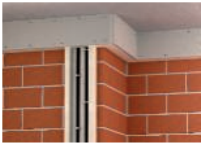
Kaablite kinnitamine klambritega - kanali vertikaalsel paigaldusel
