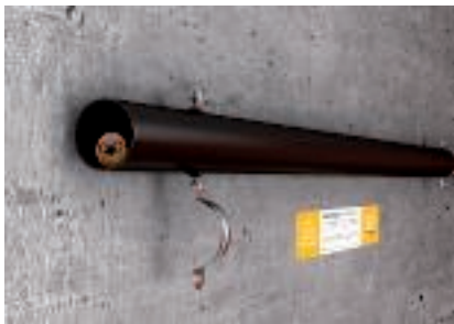
Kruvitava distantklambriga sissepanemine ülaosa kinnitamisega poldi alla
