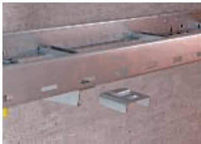
Ühendusdetaili kinnitamine redeliposti alusvööle
