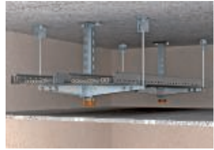
Kahekihiline rippkinnitus lakke konsoolide mõlemapoolse paigutusega
