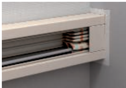
Karbikusse paigutatud padjad
