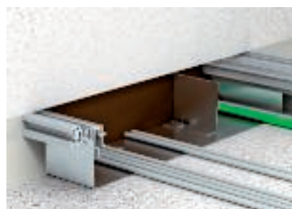
Täiendamiseks ettenähtud tühjasid tõmbetraadiga torusid võib samuti vahu sisse panna
