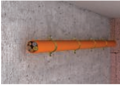
Kaablite horisontaalne montaaž seina külge
