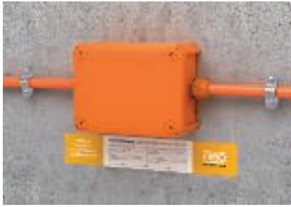
Valmiskujul paigaldatud ja tähistatud Firebox
