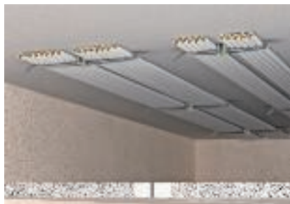
Laemontaaž ülalpool riputatud tuletõkkelaest
