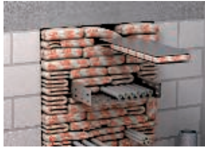
Plekid viimase padjakihi montaaži-abivahendina
