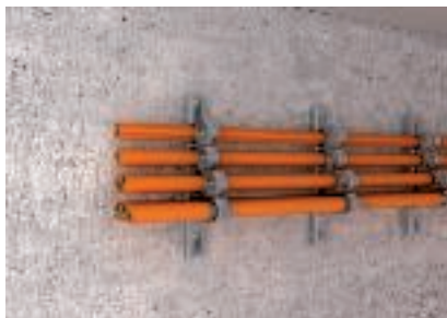
Kaablite horisontaalne montaaž U-klambritega seina külge
