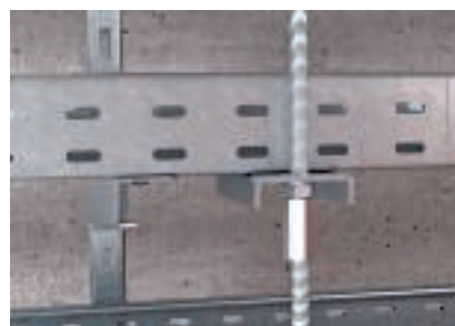
Renni keermelattkinnitus mitmekihilise paigutuse korral
