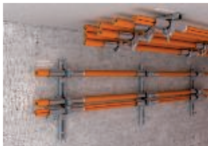
Horisontaalne montaaž U-klambritega seinale ning lae alla
