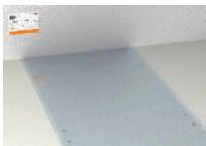
Nähtamatu tõke põrandaseguga kohakuti paiknevates põrandakanalites
