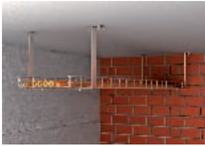
Ühekihiline laemontaaž laeklambri- riga
