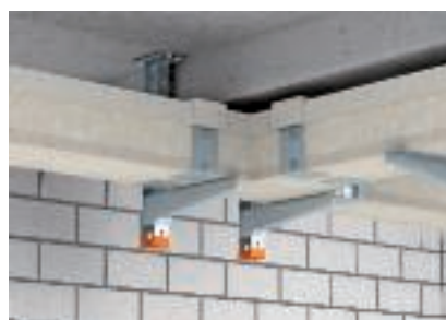
Eelmonteeritud standardsete lisadetailid kanali trassil
