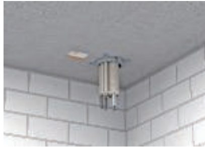
Paigaldamine lae alaküljele metalltüüblitega
