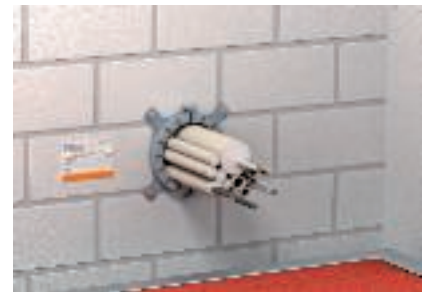
Installatsioonitorude tähistatud tuletõke
