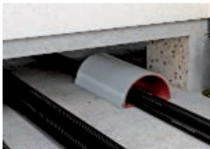
Avatud kanali asetamine tõkkeavasse
